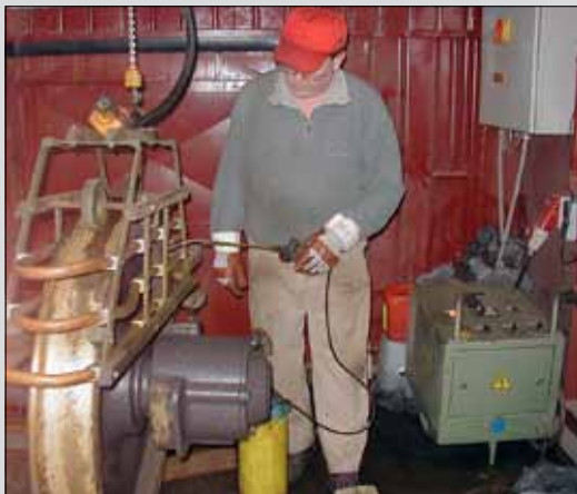
MT-Radprüfung mit Stromerzeuger und Spule
