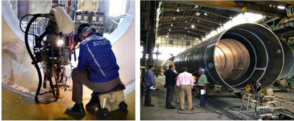
Bild 11: Windkrafttürme. Fertigung bei der Firma AMBAU.
