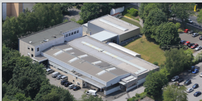
Das Werk 2 wurde für den Anlagenbau errichtet. Die erste Produktionshalle entstand 1978 und wurde in den Jahren 2004, 2006 und 2013 erweitert.
