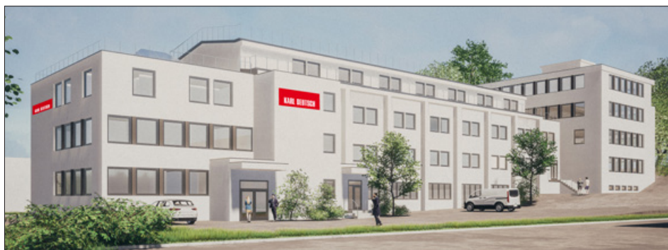
Die Umbauarbeiten für die geplante Erweiterung von Werk 1 haben begonnen.
