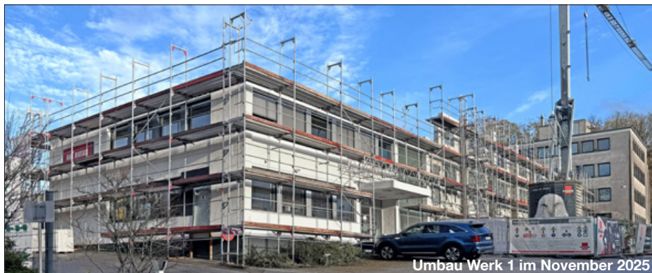
Umbau Werk 1 im November 2025
