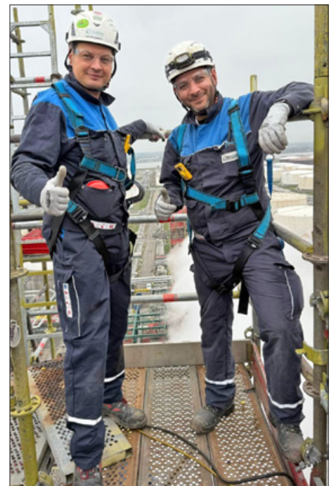
Sicherheit geht vor: Vorbereitung der Prüfung an der Tankwand
